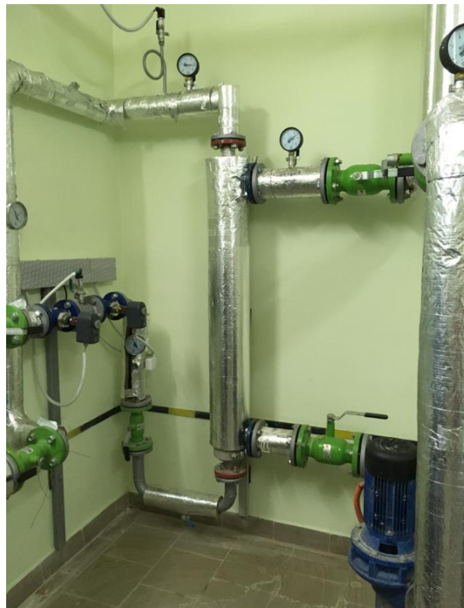
Рисунок 47 - Элементы схемы ИТП на базе кожухотрубных теплообменных аппаратов
