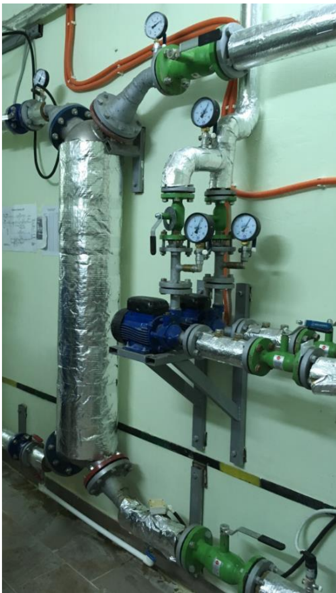
Рисунок 47 - Элементы схемы ИТП на базе кожухотрубных теплообменных аппаратов
