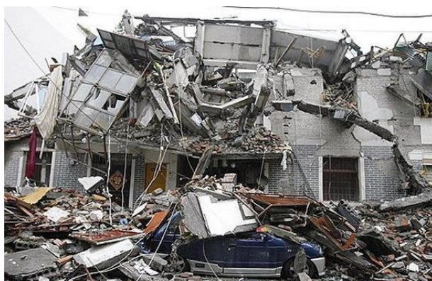
Рисунок 2 - Последствия землетрясения в Китае, 2010 г
